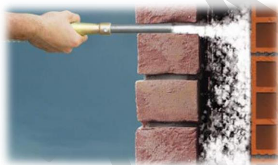
Figura 4-20: Insufflaggio delle pareti verticali.
